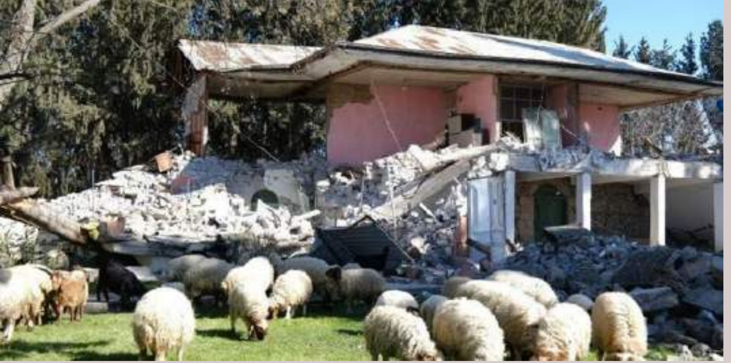
Şekil 23- Yıkılan bir ağıl ve etrafında otlayan küçükbaş hayvanlar, (Adıyaman, 2024)
