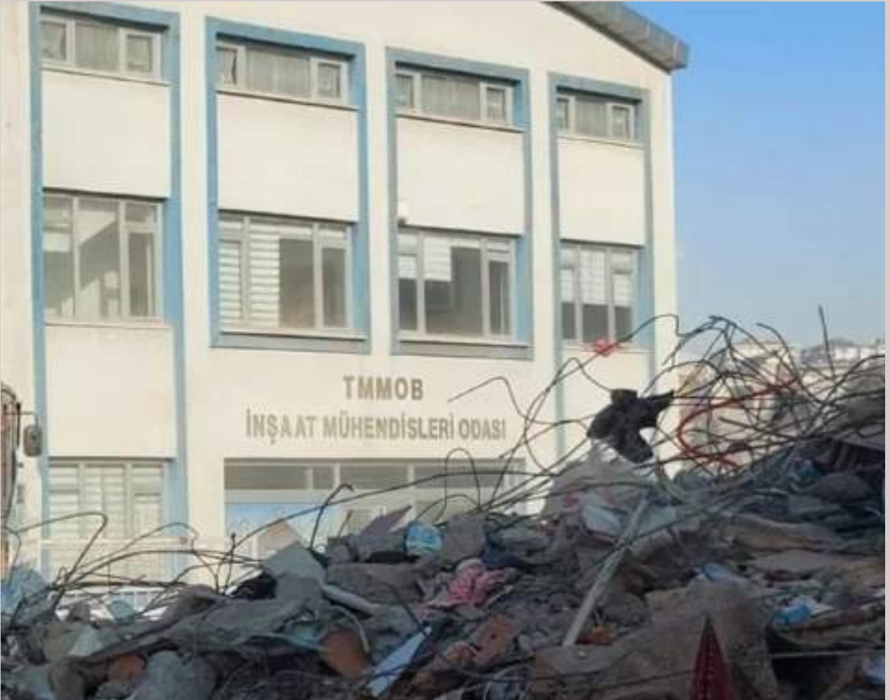
Şekil 24- TMMOB İnşaat Mühendisleri Odası Kahramanmaraş Şube Binası (Kahramanmaraş, 2023)
